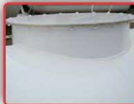
Boca Inspección con tapa abulonada
